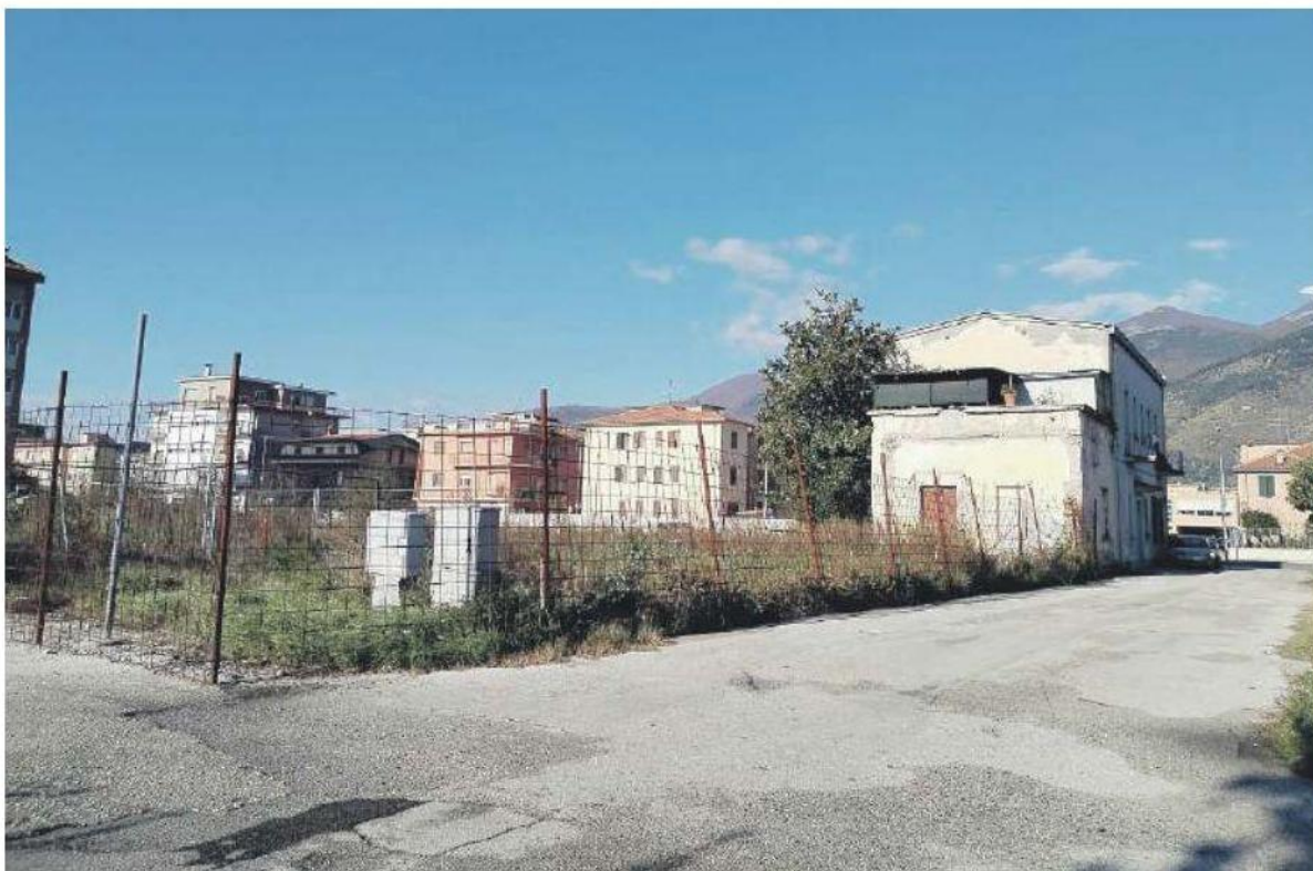
Qui sopra l'area dell'ex mattatoio dov'è in programma la costruzione della scuola innovativa progettata dal gruppo di Renzo Piano
