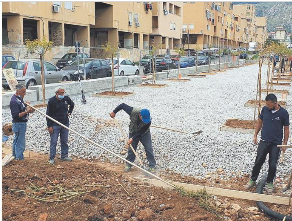
▲ Il cantiere Operai al lavoro per realizzare il giardino allo Zen 2 (foto Alessandro Lana)
