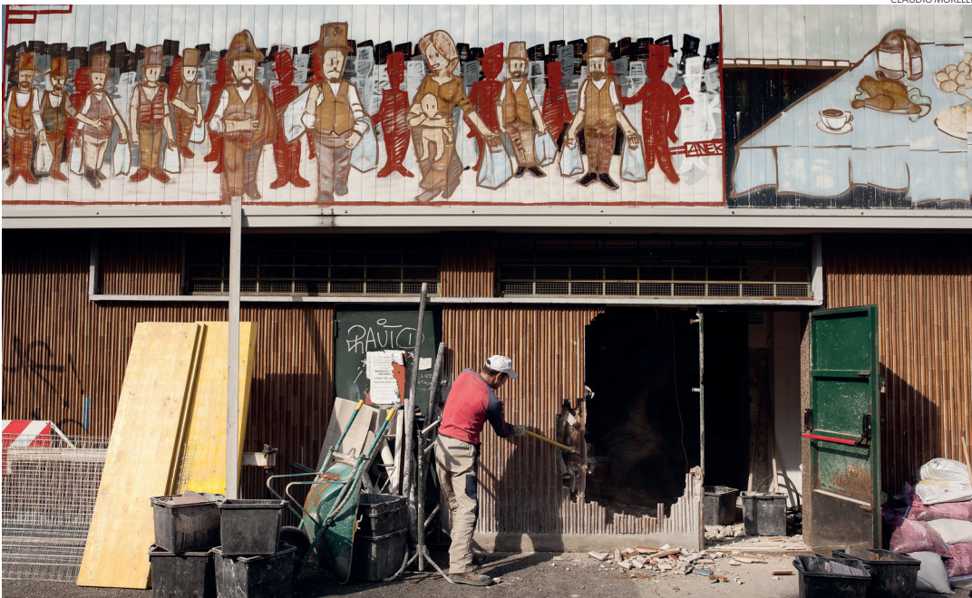
ABBATTERE I MURI | Il progetto G124 di Renzo Piano al Quartiere Giambellino di Milano: la demolizione del muro sud del mercato con l'apertura di un nuovo ingresso e la realizzazione di una pedana esterna per attività sociali
